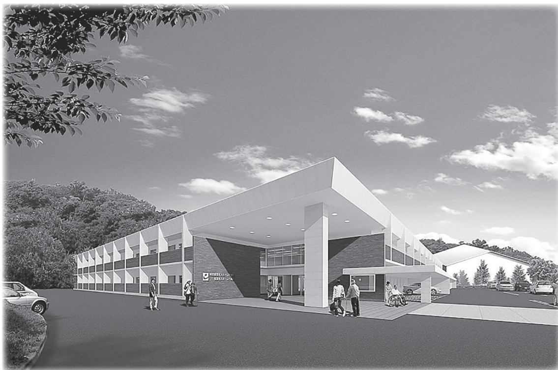
老人ホーム新施設の外観イメージ
