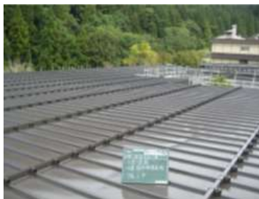
屋根塗装工事の様子
